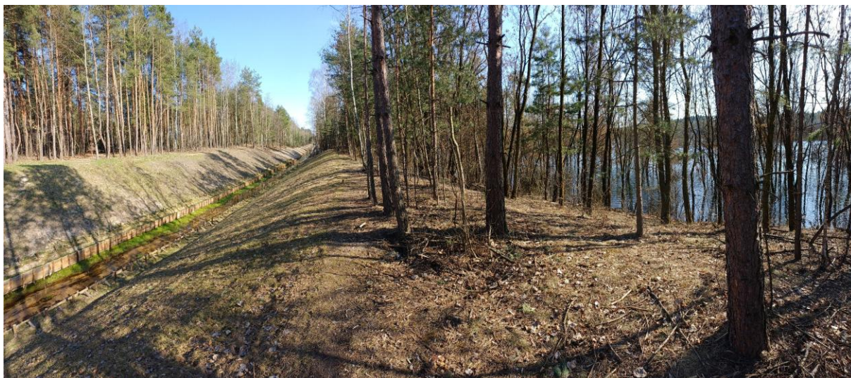
Udrożniony roznos Sztolni Ponikowskiej (z lewej) i zbiornik z podnoszącym się poziomem wody (z prawej) (18.03.2026)
