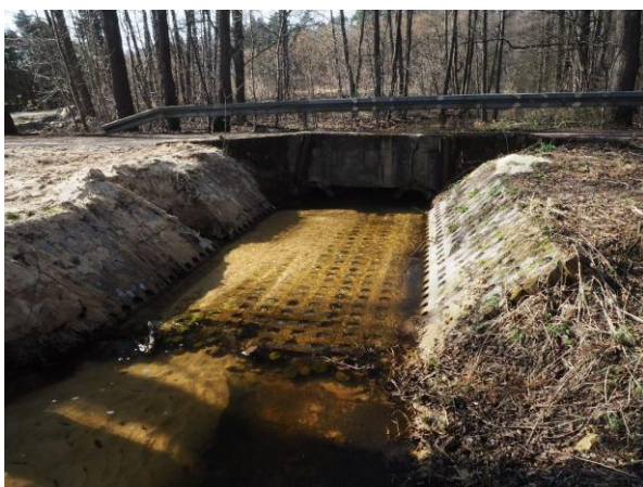
Udrożniony przepust mostu na Sztolni Ponikowskiej w Cegielni (lewe) oraz rozlewisko poniżej tego przepustu (prawe) (18.03.2026)
