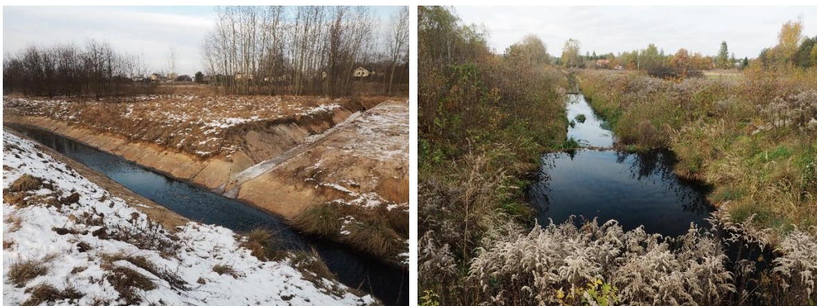
Udrożniony fragment Dąbrówka powyżej drogi DK94 wraz z wykonanym drenażem terenów położonych w sąsiedztwie (lewe, 2.01.2026) oraz stan siedliska bobrów w poniżej mostu w ciągu ul. Bolesławskiej/Laskowskiej (prawe, 22.10.2025), fot. A. Tyc
