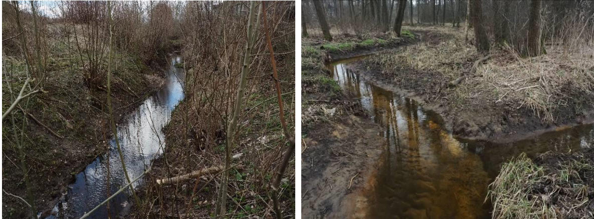
Sztolnia Ponikowska na zabudowanym terenie Lasek (lewe) oraz ujście Sztolni Bolesławskiej do Sztolni Ponikowskiej w Laskach, tuż po zakończeniu prac udrażniających koryta tych cieków (prawe), 1.03.2024, fot. A. Tyc
