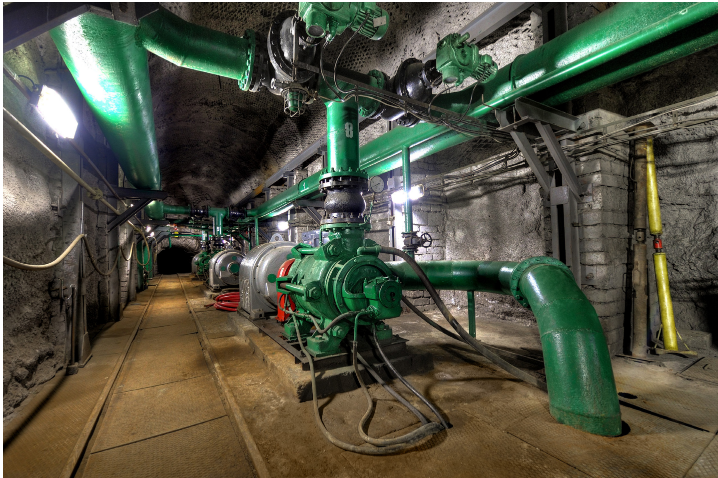
Pompa OW-300 produkcji Zabrzeńskiej Fabryki Maszyn Górniczych „Powen” (fot. Krzysztof Boniecki)
