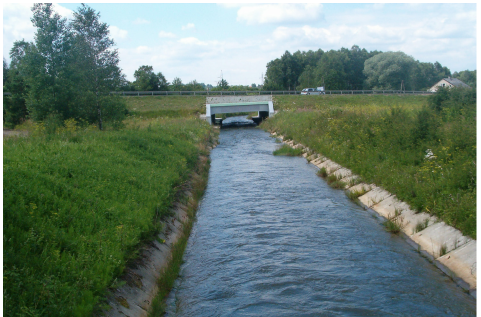
Kanał Dąbrówka przed przepustem drogowym DK94 (fot. archiwum autora)
