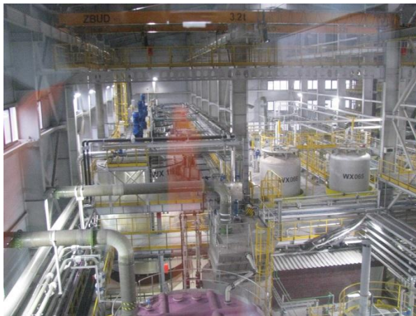
Ciąg technologiczny wewnątrz budynku.
