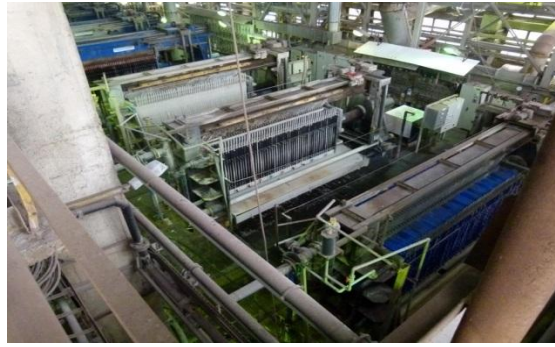
Prasy filtracyjne II i III stopnia.
