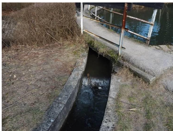
Odptyw nadmiaru wody ze stawów przy Leśnym Dworze bocznym przepustem do rzeki Sztoły (14.02.2024), fot. A. Tyc
