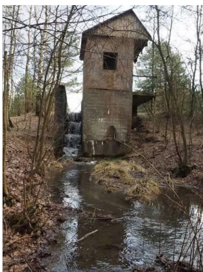
Odptyw nadmiaru wody ze stawów przy Leśnym Dworze bocznym przepustem do rzeki Sztoły (14.02.2024), fot. A. Tyc
