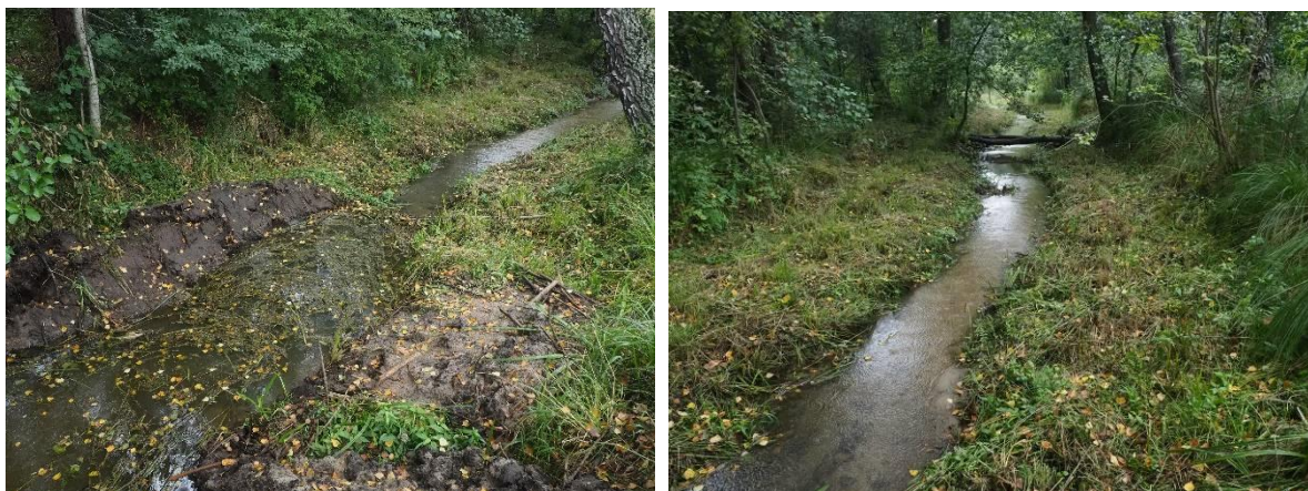
W drugiej połowie sierpnia udroźniony został roznos Sztolni Bolesławskiej i Ponikowskiej powyżej ujścia do Białej w Laskach – pogłębione zostało koryto roznosu w miejscu rozebranej tamy bobrowej (lewe) oraz wykoszone zostały pas roślinności wzdłuż brzegów (prawe) (19.08.2023), fot. A. Tyc
